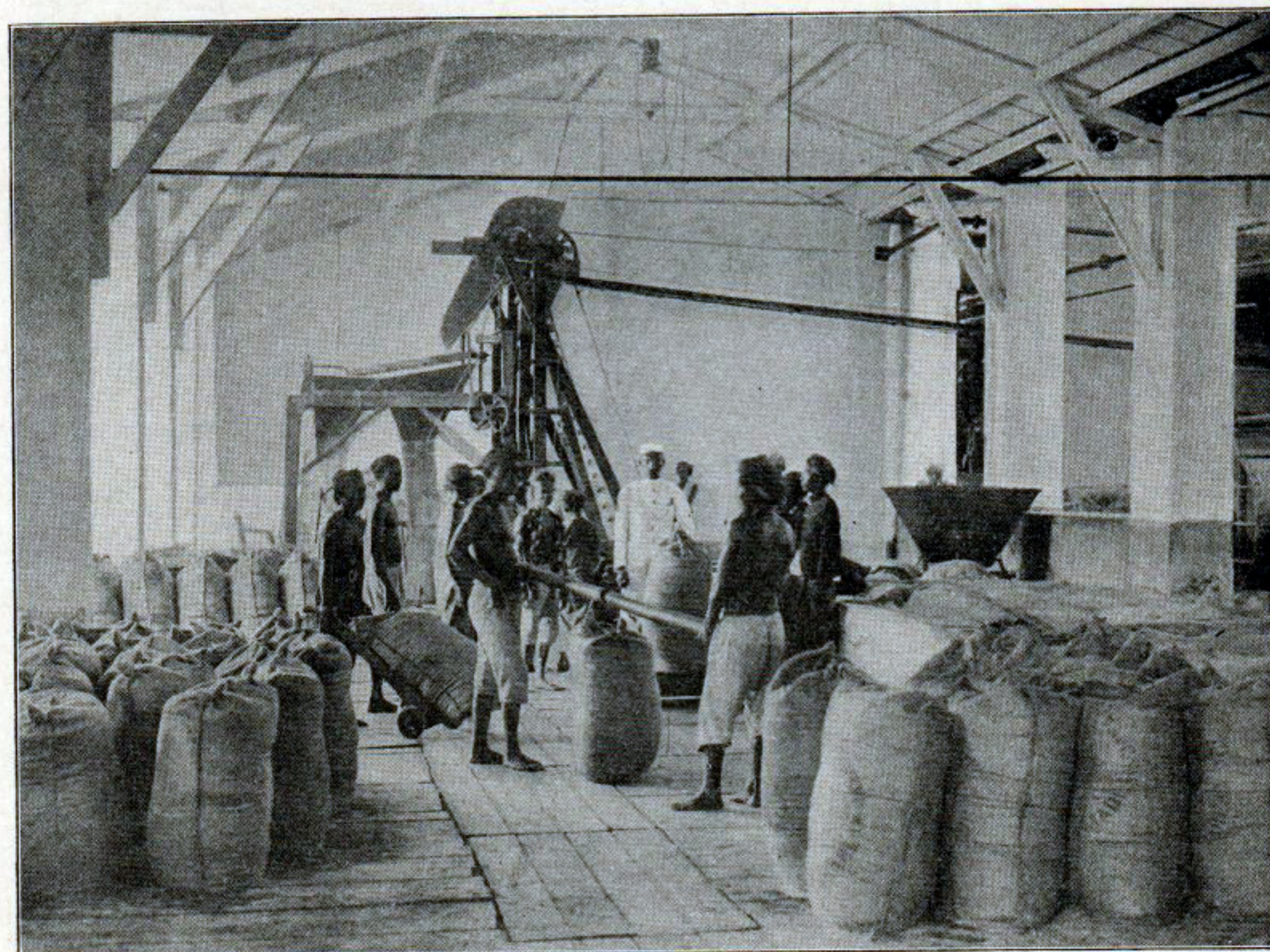
302. VERPAKKING VAN DE SUIKER IN JUTE-ZAKKEN. 302. MEMASOEKKAN GOELA DIDALAM KAROENG.
