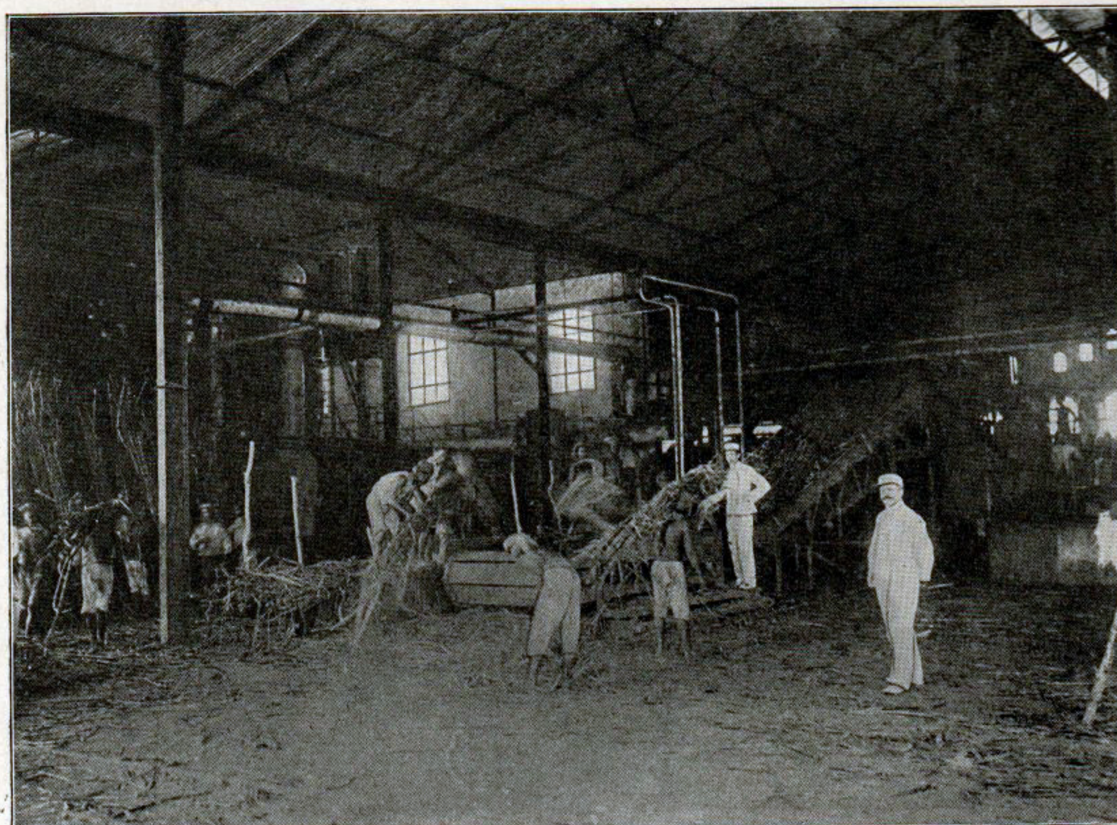
299. HET RIET WORDT OP DE CARRIER GELEGD EN VOORTGESCHOVEN NAAR DE MOLENROLLEN.
