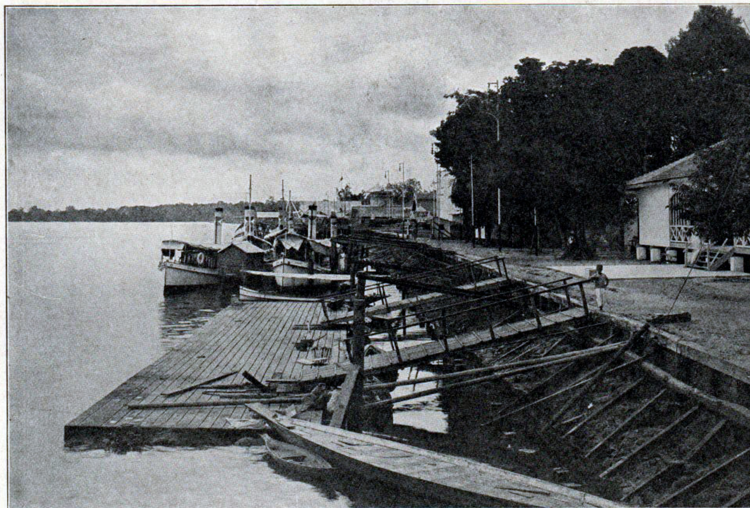
453. AANLEGKADE BIJ HET ÉTABLISSEMENT TE PLADJOE. 453. TJEROTJOK PADA SOENGAI MOESI, OENTOEK PABERIK MINJAK TANAH DI PLADJOE.
