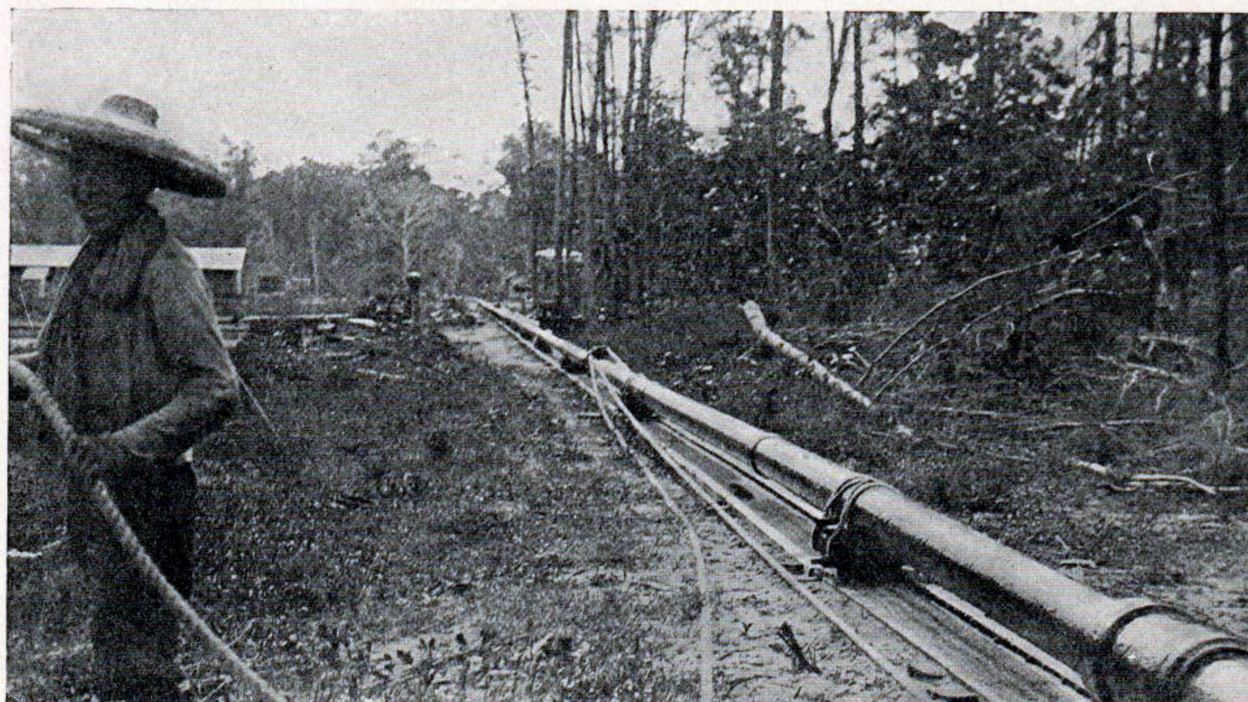
447. VERVOER DER RUWE OLIE DOOR EEN PIJPLEIDING NAAR DE RAFFINADERIJ. 447. MENGALIRKAN MINJAK KEPABERIK DENGAN BEROEMBOENG BESI.
