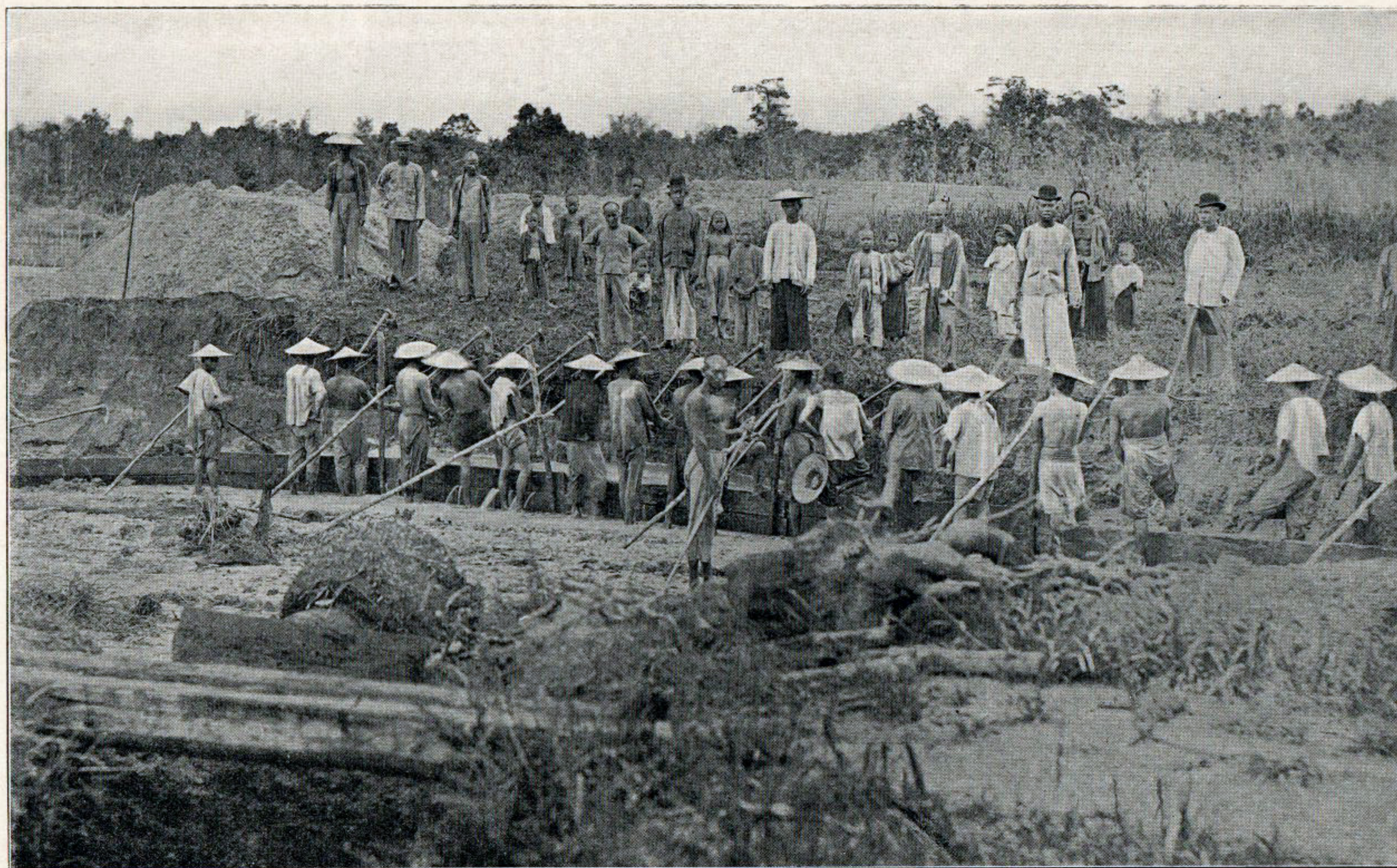
460. GRONDVERZET DOOR SPOELING IN EEN TINMIJN OP BANGKA.
