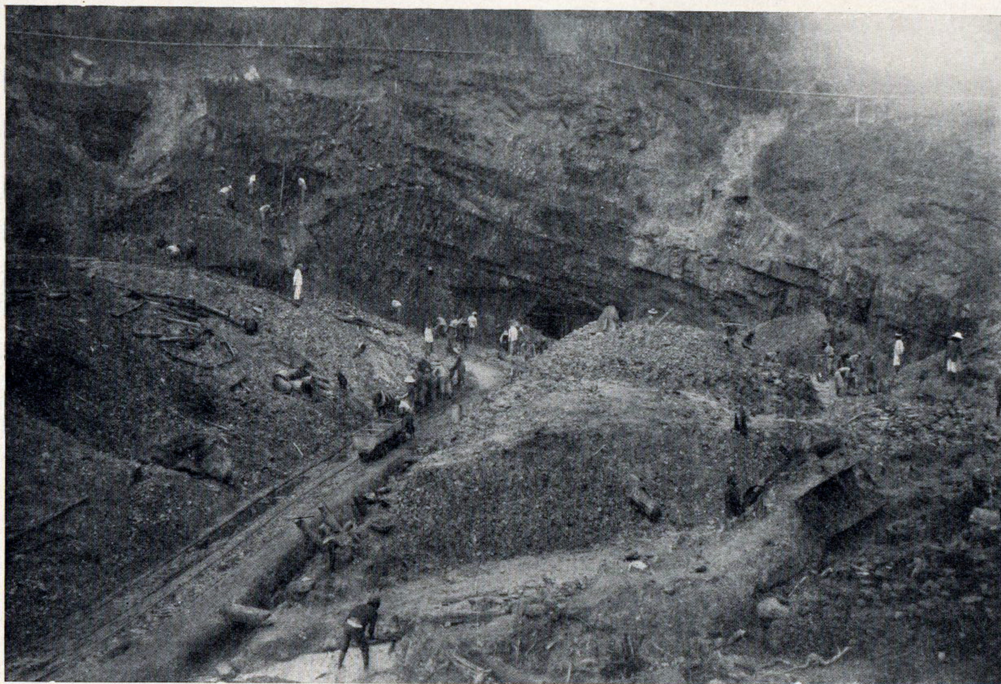
465. BOVENGRONDS MIJNWERK VOOR STEENKOLENWINNING. Ned. Indië heeft drie Gouvts-steenkolenwinningen, n.l. 1°. Sawahloento (Sumatra's Westkust); 2°. Poelau Laoet (eiland ten Z.O. van Borneo; afvoer te Stagèn) en 3°. Boekitasem (te Tandjoeng aan de Enim, zijrivier van de Lematang, afvoer per spoor naar Kertapati tegenover Palèmbang). Particuliere steenkolenontginning zijn die van de Oost-Borneo Maatschappij in de omstreken van Samarinda, die te Rantapandjang, nabij Teloekbajoer, aan de Beraoe-rivier gelegen, eveneens aan de Oostkust van Borneo, van de Kon. Paketvaart Maatschappij, en een aantal kleinere.
