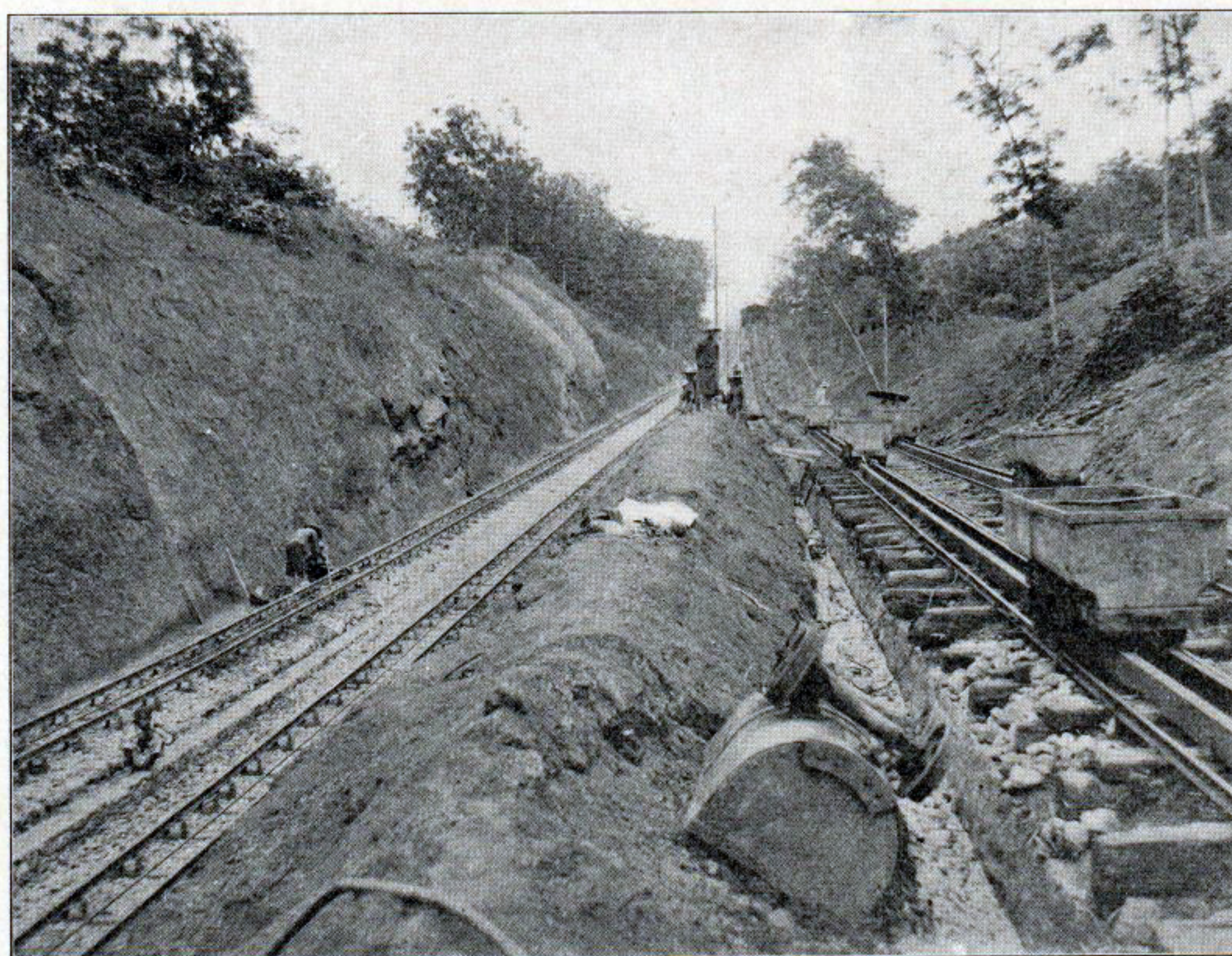
470. SAWAHLOENTO. REMHELLING VOOR TRANSPORT MET BAND ZONDER EINDE; RECHTS DE OUDE, LINKS DE NIEUWE.
