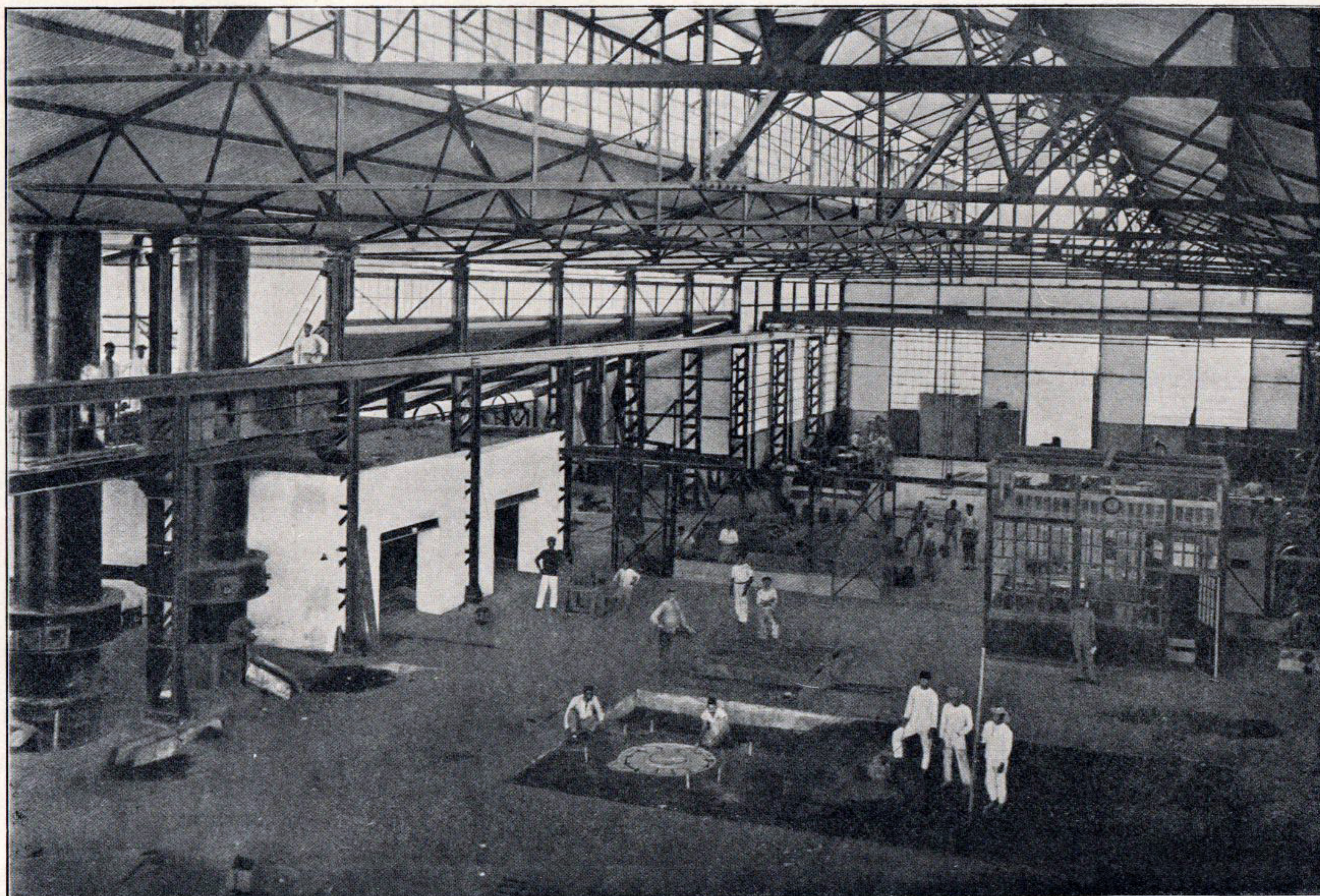
120. BINGKIL DI-BANDOENG. ORANG TENGAH MELEBOERKAN BESI. Bingkil ini paberik jang terbesar di-Hindia ini. Beriboe 2 orang negeri beladjar pertoeangan jang pandai disini. Segala perkakasnja dipoetarkan atau didjalkan djalaran lesterik.
