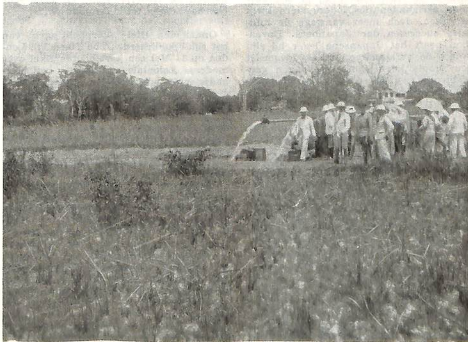
Waterwinplaats ten behoeve van den aanleg van de waterleiding voor Paramaribo, welke sedert ruim 10 jaar genoemde plaats van uitstekend drinkwater voorziet, dat voorheen door iederen bewoner verzameld moest worden in regenbakken, die bij abnormale droogte gewoonlijk leeg waren.
