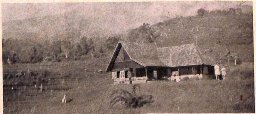
Dit is het model semi-permanente tropenhuis, zoals door ir. Koops-Dekker, uit plaatselijk materiaal opgebouwd.
