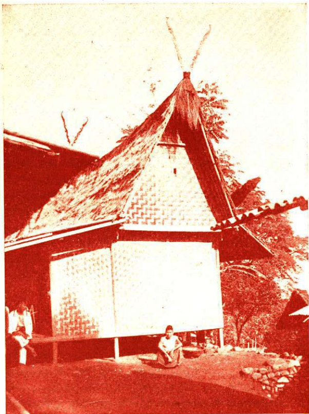
Oud-Soendanees huis, zoals dat nog in bergdessa's gevonden wordt. De dakvorm met overstekken heet „djoelang ngapak” (neushoornvogel met gespreide vleugels). Het uitsteeksel op de nok heet „djagak goenting” (schaar-stijl).
